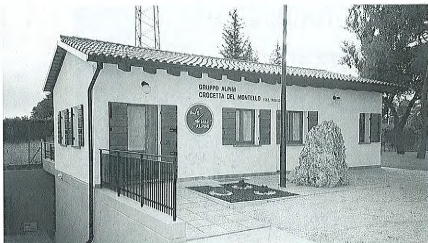
I lavori per la costruzione della Sede, sono iniziati nel 1998 e terminati nel 2000. La Sede è stata inaugurata il 24.9.2000 ed è situata in Via Piave.
